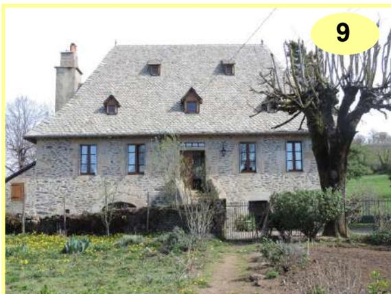
Les chaînes d'angle et les encadrements sont en pierre de taille. Ces chaînages en pierre de taille bloquent les appareillages en moellons des murs. La construction est précédée d'un enclos cerné d'un muret de pierres sèches. Deux piles en pierres appareillées font office de porche.
